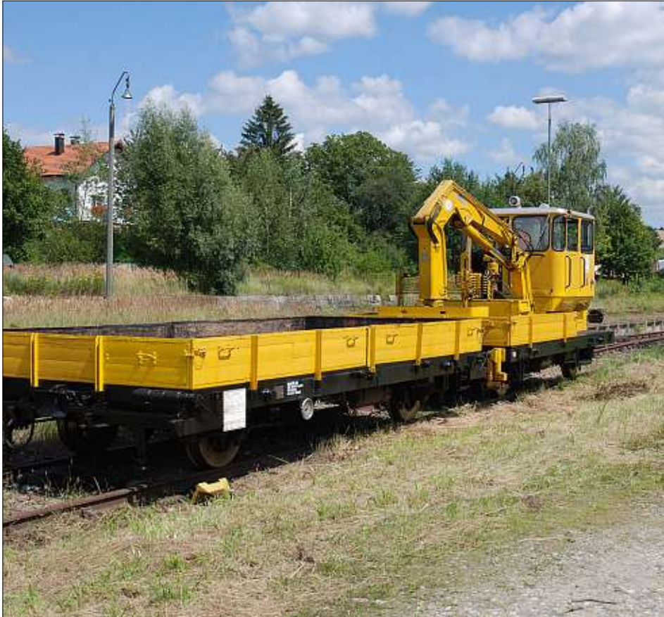
Die Baulok der ITB ist seit Freitag auf der Bahnstrecke zwischen Freyung und Waldkirchen unterwegs... – Foto: Seidl
